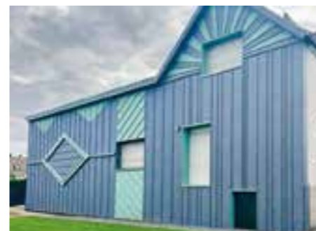
Fassadenbekleidung durch unsere Spengler-Fachkräfte
