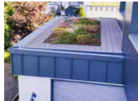
Kombinierte Flachdachabdichtung mit Gründachfläche
