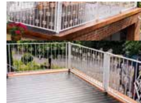
Balkonsanierung mit WPC-Terrassendielen
