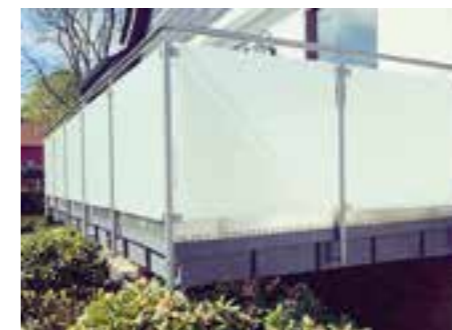
Balkonsanierung mit Geländerbau
