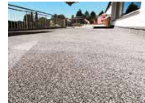
Balkonsanierung mit einem Granulat-Natursteinbelag
