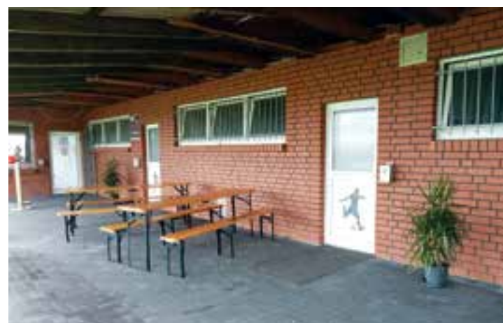
Der Bereich vor den Umkleiden wurde saniert, bekam ein neues Dach und neues Pflaster.
