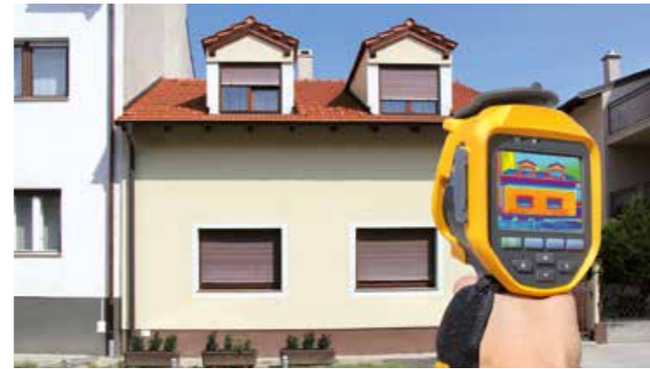
Erst den Ist-Stand analysieren, dann einen konkreten Sanierungsfahrplan aufstellen. Mit einem Infrarot-Messgerät kann der Energieberater Schwachstellen in der Gebäudehülle identifizieren. Foto: djd/Qualitätsgedämmt e. V./smuki - Fotolia
