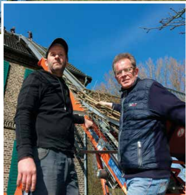
Der Bergkamener Dachdecker Thomas Schlossarek und der Ökostationshausmeister Dieter Köster beim Installieren des neuen Wohnraumes. Fotos: Ralf Sängers
