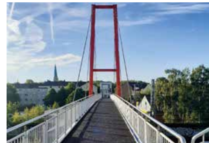
Brückenüberbau - neuer Gussasphalt. Foto: © Gemeinde Holzwickede
