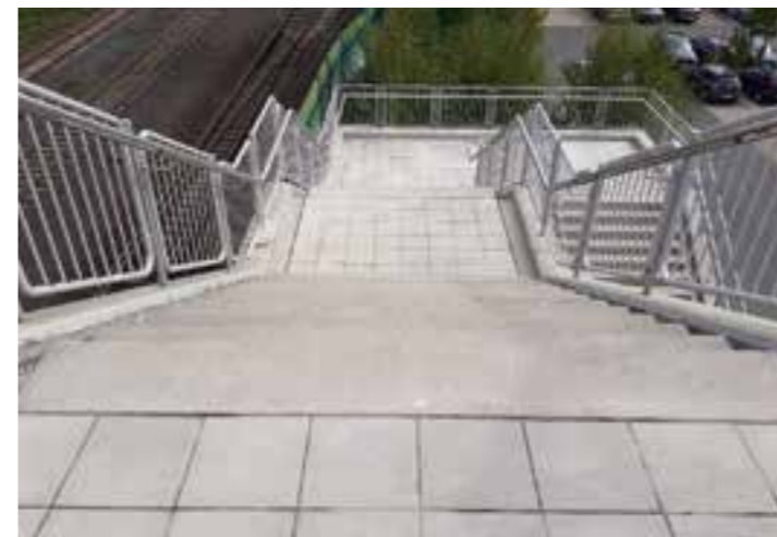
Treppenpodeste - neue Beton Gehwegplatten. Foto: © Gemeinde Holzwickede
