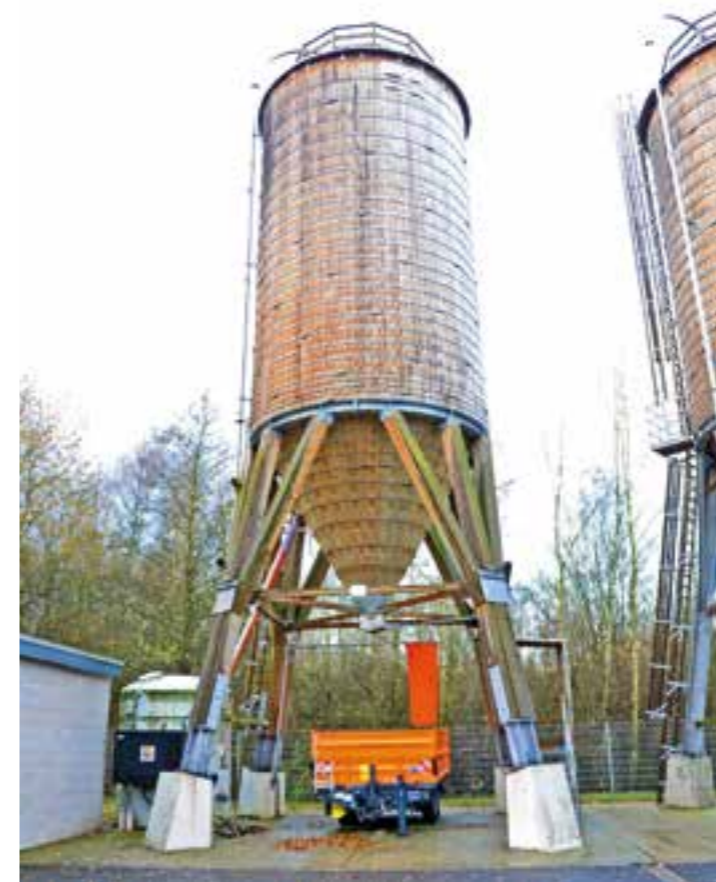
Silo Bauhof: Die Salzlager sind gefüllt. In diesem Silo lagern 250 Tonnen. Insgesamt werden am Kreis-Bauhof in beiden Silos 500 Tonnen bereitgehalten und bei Bedarf auf die Fahrzeuge verteilt.
